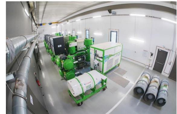
Figure: Poste 63 kV de GRIMAUD: expérimentation du premier poste RTE à gaz isolant à faible effet de serre, mis en service en juin 2019.
